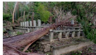
台風21号による被害
